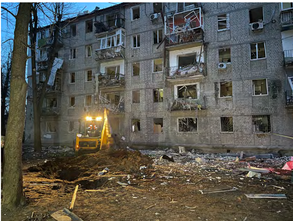
ВИРВА ВІД ПЕРШОГО УДАРУ АВІАБОМБИ УМІБ Д-30СН ПО ХАРКОВУ. 27 БЕРЕЗНЯ 2024.
